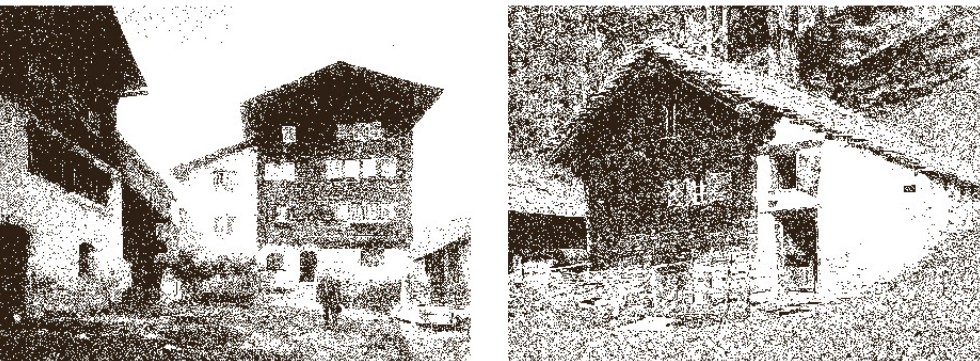
Walliser Mischbauweise mit massivem Stall und Wohnteil in Holz
