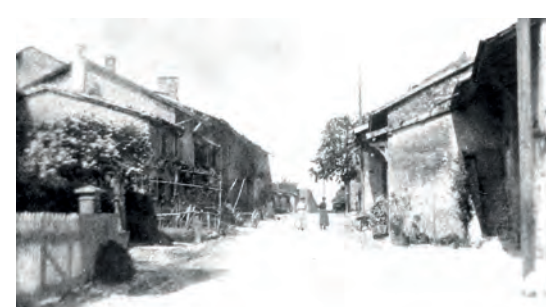
Choulex, constructions en ordre contigu, rue principale
