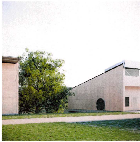
Die neue Zufahrtsrampe führt an Gewerbehau vorbei und mündet im Werkhof - einem Zwischenraum, der von zwei linearen Baukörper abgegrenzt und vom Baumreichtum gehalten wird.
