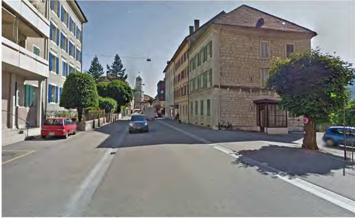
Referenzbild: Übergang Trottoir / Strasse, Gemeinde St. Imier, BE
