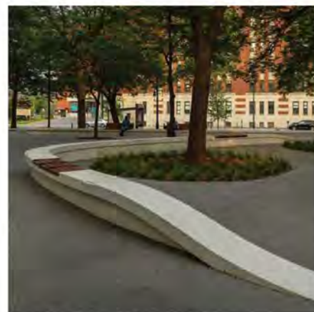
Vertikal mäandrierende Betonsitzmauer
