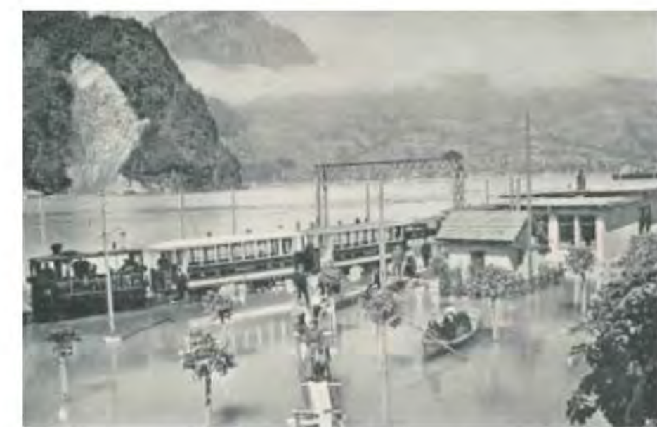
HOCHWASSER IN STANSSTAD
