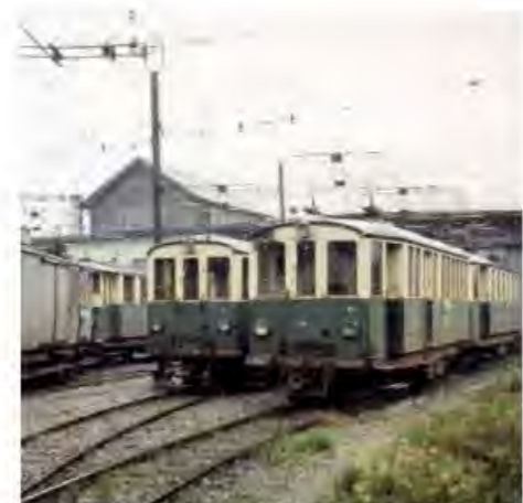
Zugdepot der Stansstad – Engelberg Bahn (StEB) Die Parzelle befindet sich auf dem ehemaligen Gleisfeld 1964, P. Sutter, Archiv Tramclub Basel
