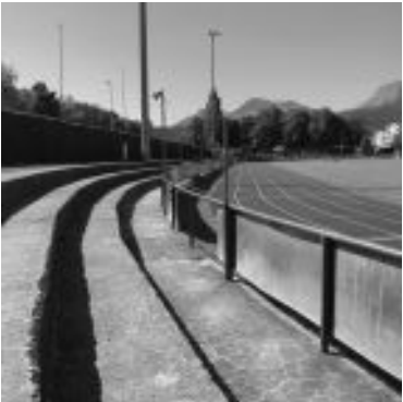
L'état de l'enceinte et des gradins
