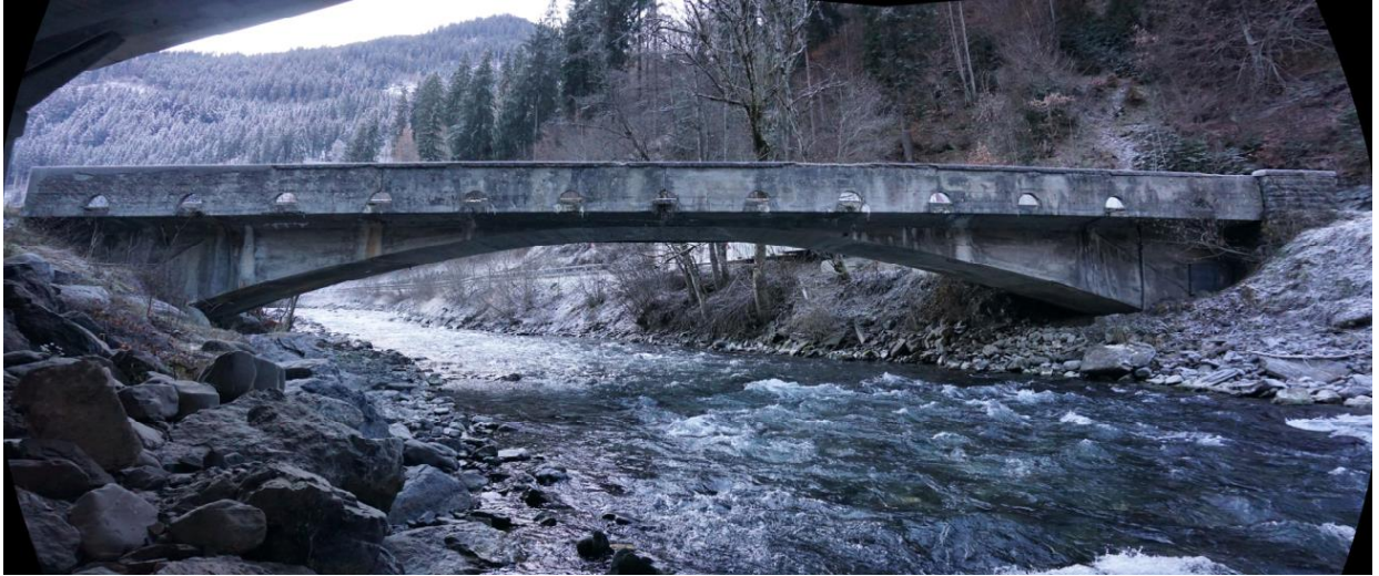
Abbildung 2: Die alte Landquartbrücke Dalvazza aus dem Jahre 1930; Blickrichtung flussaufwärts
