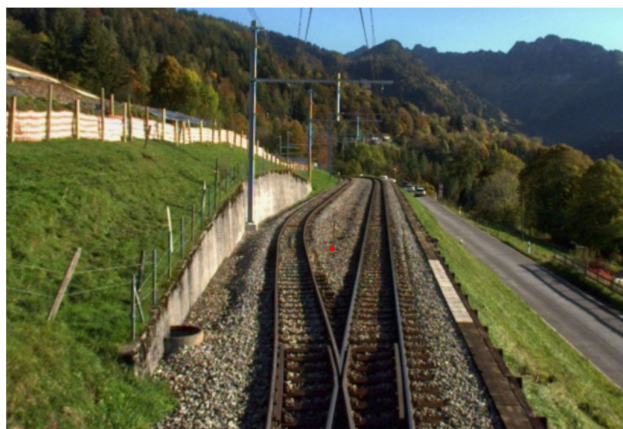
Figure 9 - Mur poids à l'amont des voies (km 9.050 - km 9.110)
