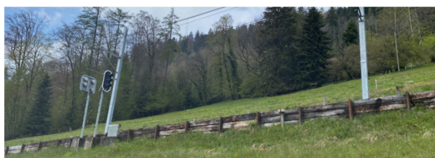
Figure 10 - Palissade de soutènement à l'aval des voies
