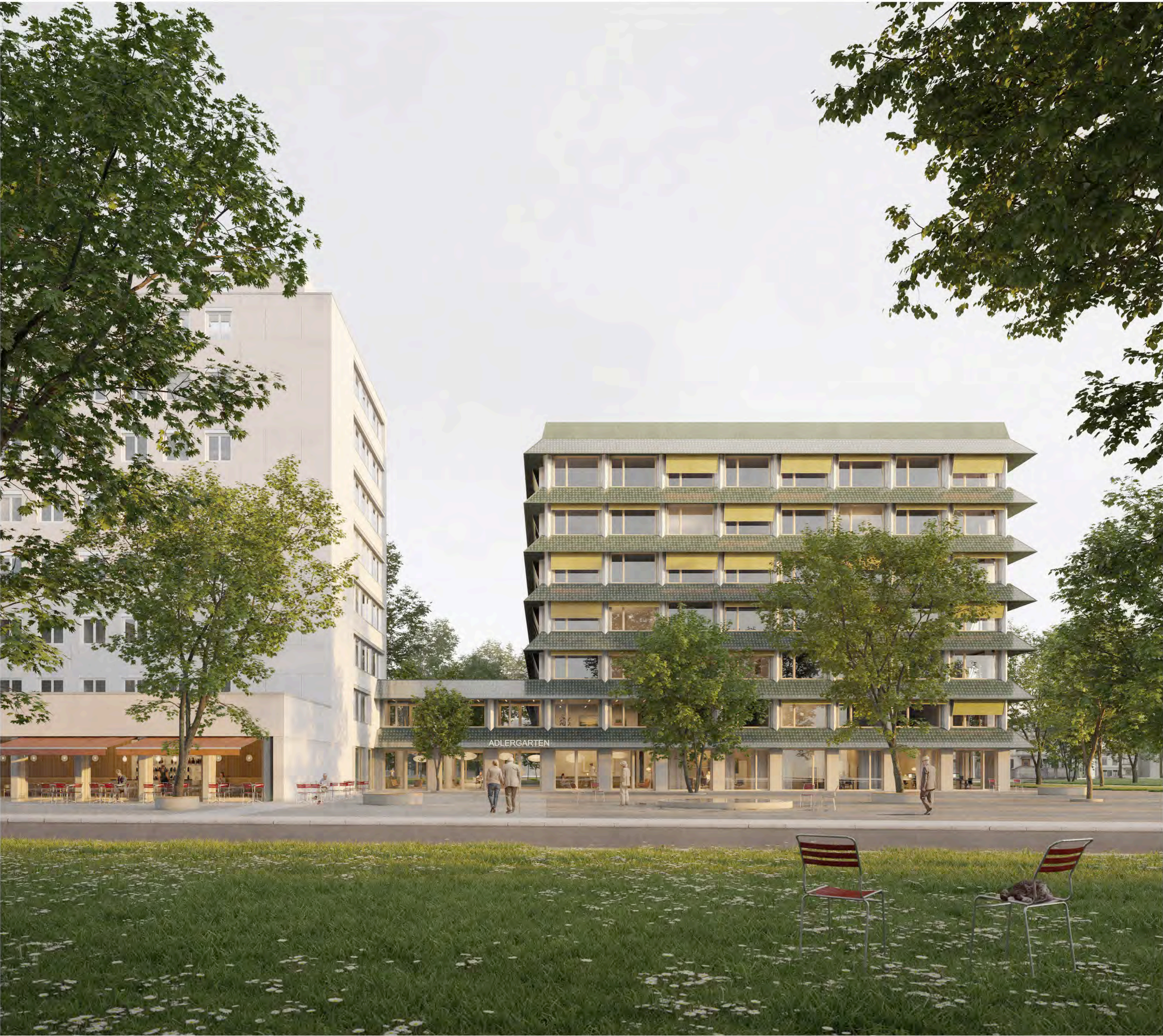
Der neue Vorplatz im Norden leitet die gemeinsame Adresse des Alterszentrums Adlergarten ein. Die schmale zweigeschossige Verbindung, welche die Sockelgeschosse des Neubaus mit dem Bestandsgebäude verknüpft markiert auf der Platzseite den neuen Zugang zum Gebäudeensemble Adlergarten. Auf dem Vorplatz stehend, zeichnet sich die Parkanlage mit ihrem wertvollen Baumbestand hinter der grosszügigen Eingangshalle deutlich ab.
