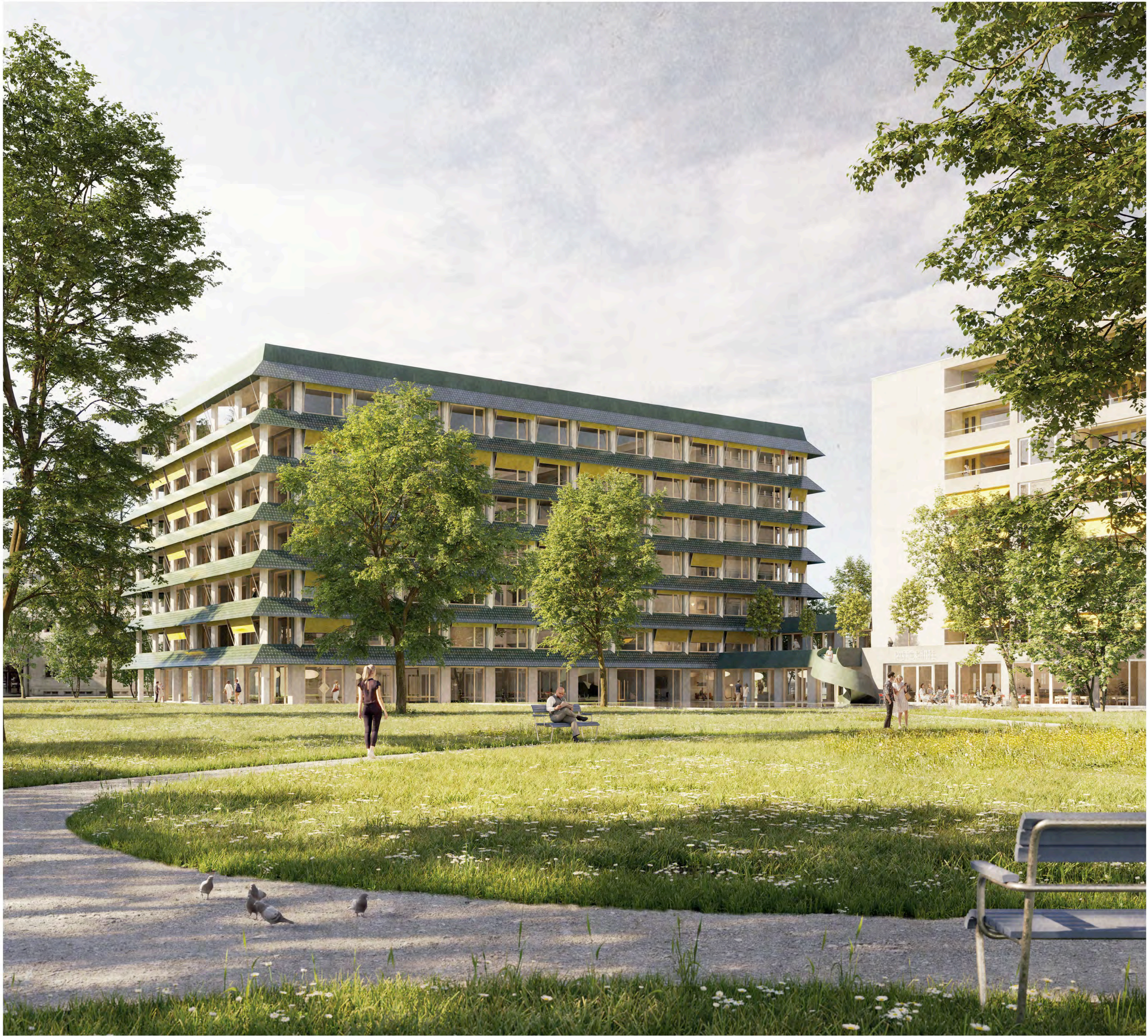
Der Ausdruck des Hauses wird von einem horizontal verlaufenden und diagonal ausgestelltem „brise-soleil“ bestimmt, welcher einen signifikanten Beitrag zum sommerlichen Wärmeschutz leistet. Die dezent spiegelnden Oberflächen der transparenten Photovoltaik-Glaspaneele lassen die dahinterliegende tiefrüne Metallkonstruktion in Erscheinung treten, die einen starken Dialog mit dem Kolorit der Landschaft sucht.
