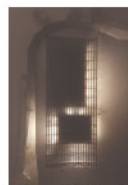
Deckenlicht reflektiert beleuchtete Fachwerkträger
