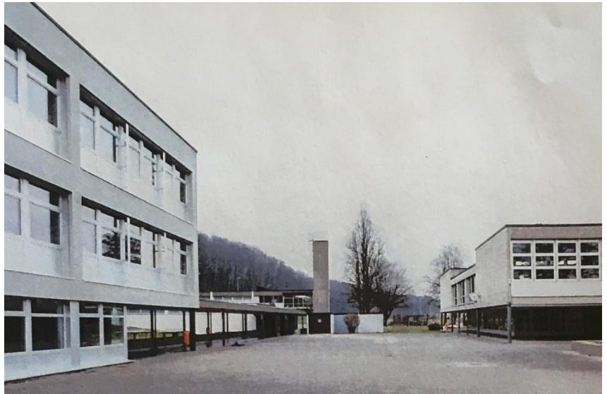
Abbildung 3.: Sicht von Westen auf die Gebäude HB I und HB II
