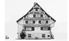
Foto 2: Klebdächer, Altdorf SZ
