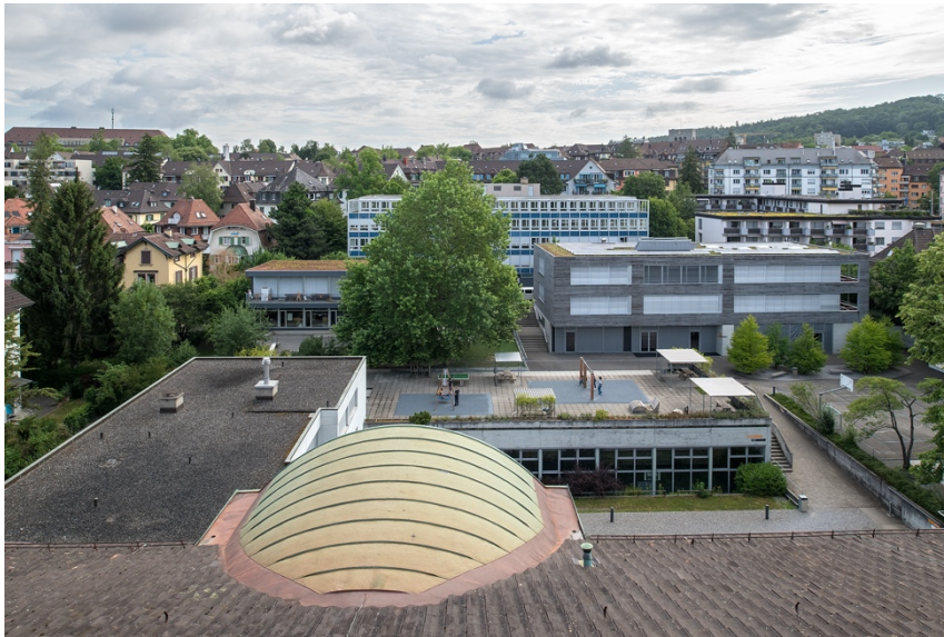
Abb. 07 Blick aus dem Hauptgebäude in Richtung Nordosten: Links Zwischenbau, Mitte Turnhalle, hinten Institut und GSU
