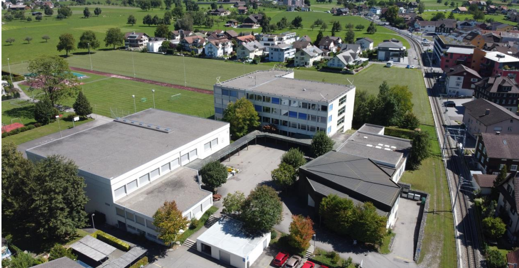
Abbildung: Schulanlage Pestalozzi, Quelle: Schule Pestalozzi
