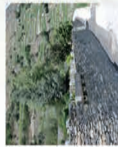
Des murs de soutènement en pierre sèche
