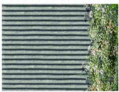
Mur extérieur du local technique
