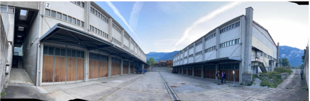
Innenhof, Sicht in Richtung Norden
