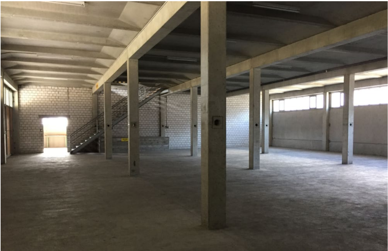
Erdgeschoss (Beispielbild, Halle Ost)
