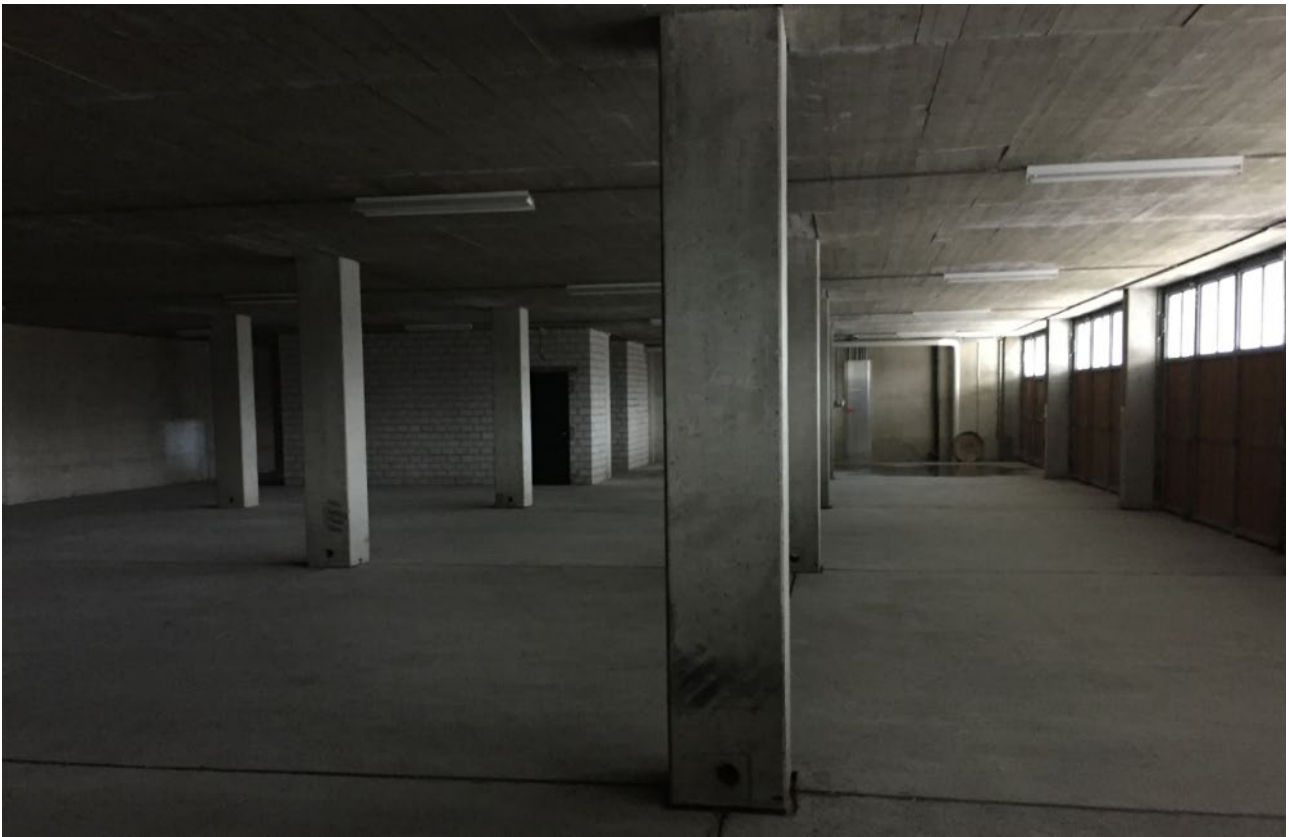
Untergeschoss (Beispielbild, Halle Ost)
