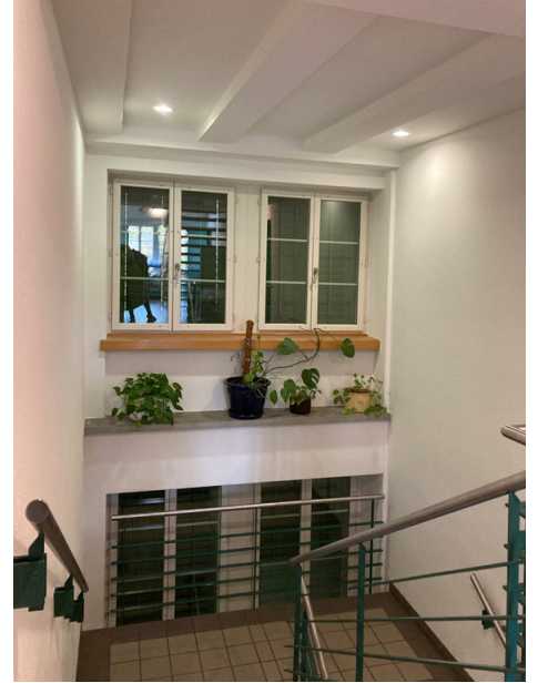
Treppenhaus Erd-, 1. Obergeschoss
