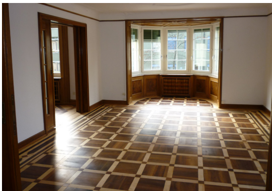
Ehemalige Arztpraxis Freiestrasse 217, saniert 2010
