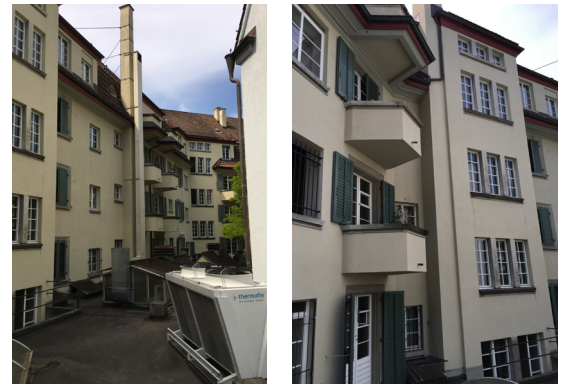
Terrasse / Hofbereich Forchstrasse 193 ( 1.OG )
