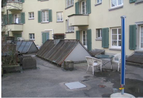
Terrasse Bereich Freiestrasse 221 ( 1.OG )
