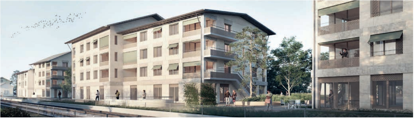
Vue depuis les voies ferrées
