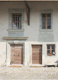
Un espace pavé devant les bâtiments - Avary
