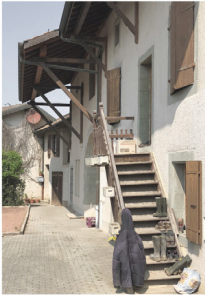
Des avant-toits pour faciliter l'appropriation
