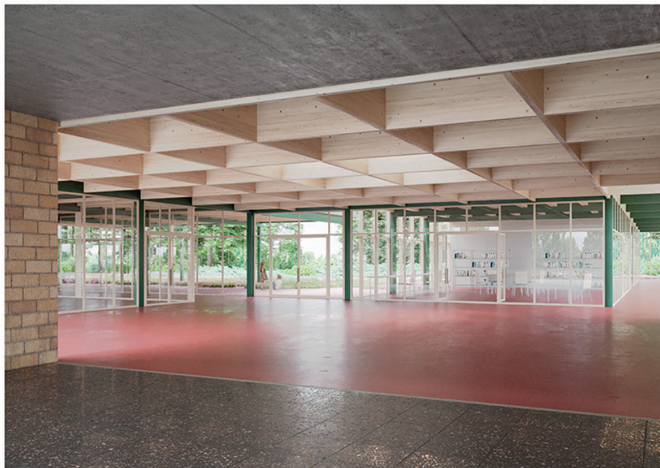
Vue de l'espace de circulation, connexion entre l'ancienne et la nouvelle école
