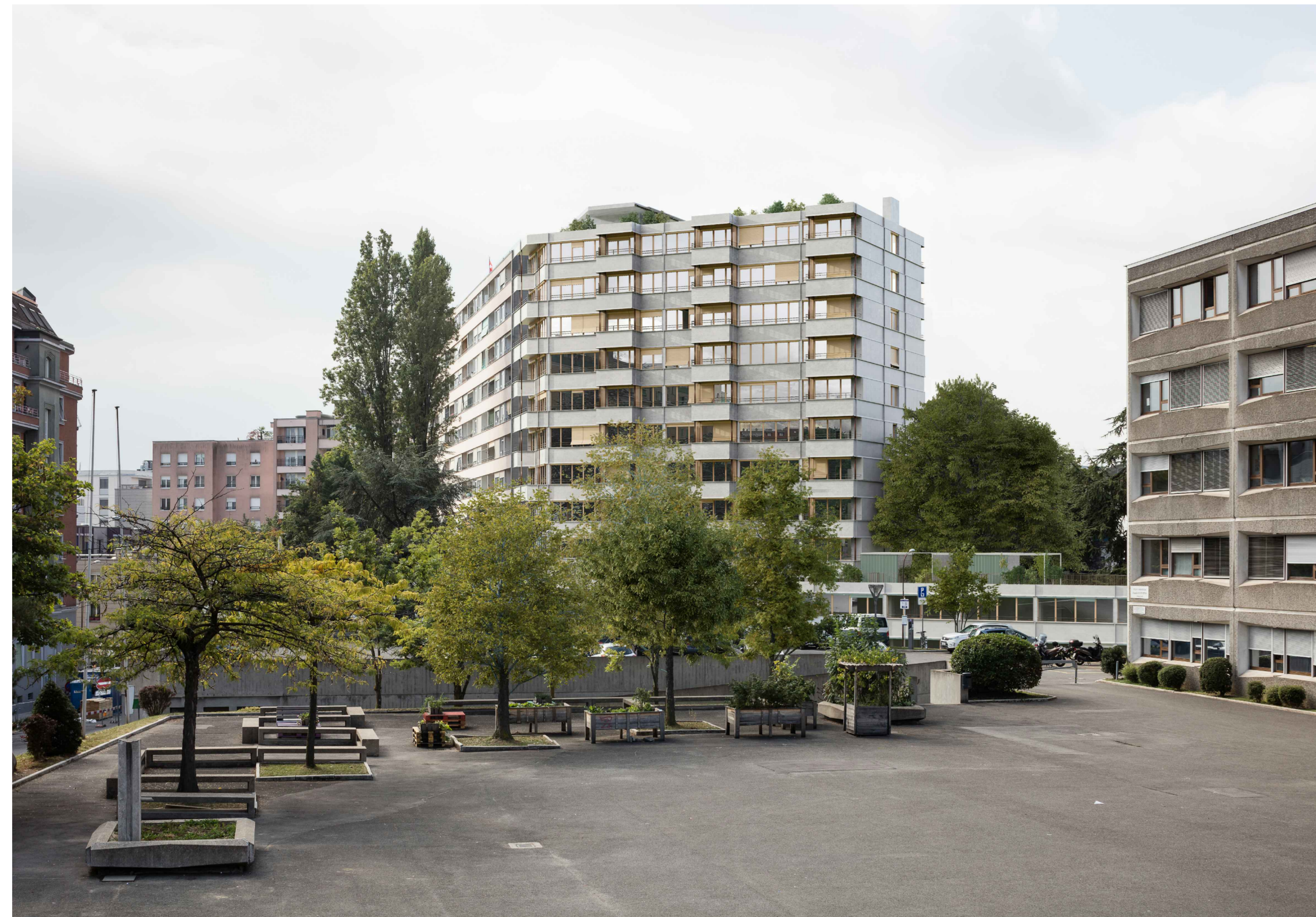
Vue depuis le préau du Collège de Sécheron
