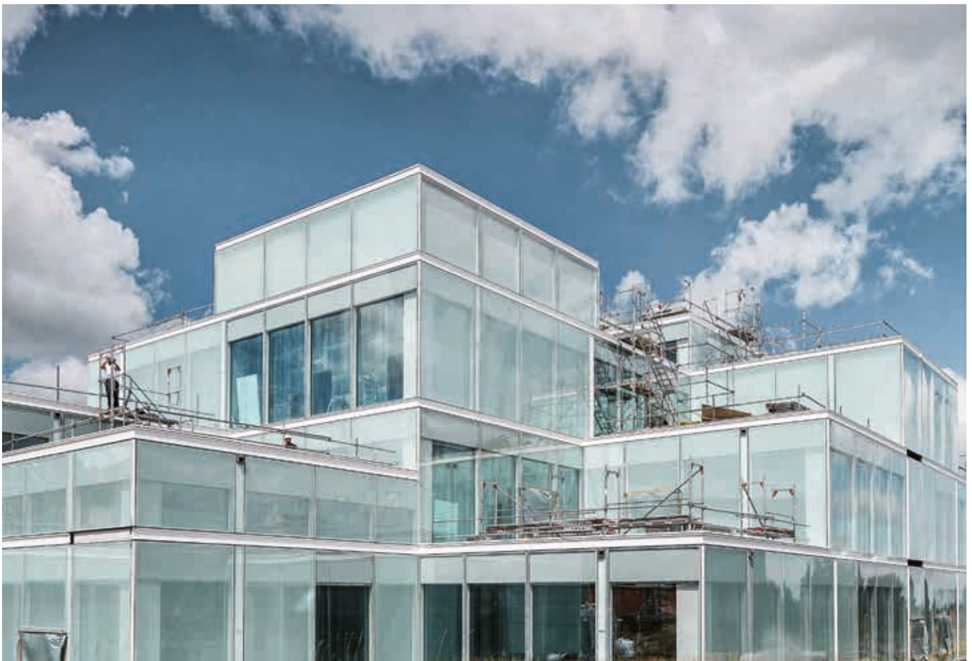
2 Neubau Square der Universität St. Gallen, Architektur Sou Fujimoto: Die 448 Fassadenelemente (geschlossene Doppelhautfassade mit innen liegenden Rafflamellenstoren) sind direkt miteinander verbunden, wurden vorproduziert und liessen aufgrund der brüstungslosen Montage keine Toleranzen zu. Nouveau bâtiment Square de l'Université de Saint-Gall, architecture de Sou Fujimoto: les 448 éléments de façade (façade double peau fermée avec stores à lamelles intérieures) sont directement reliés entre eux, ont été préfabriqués et n'ont permis aucune tolérance en raison du montage sans allège. Nuovo edificio Square dell'Università di San Gallo, architettura di Sou Fujimoto: i 448 elementi dell'involucro (facciata chiusa a doppia pelle con lamelle a pacchetto interne) sono direttamente collegati tra loro, la prefabbricazione non ha consentito alcuna tolleranza a causa dell'assemblaggio senza parapetti. FOTO: HSG STIFTUNG | CHRIS MANSFIELD
