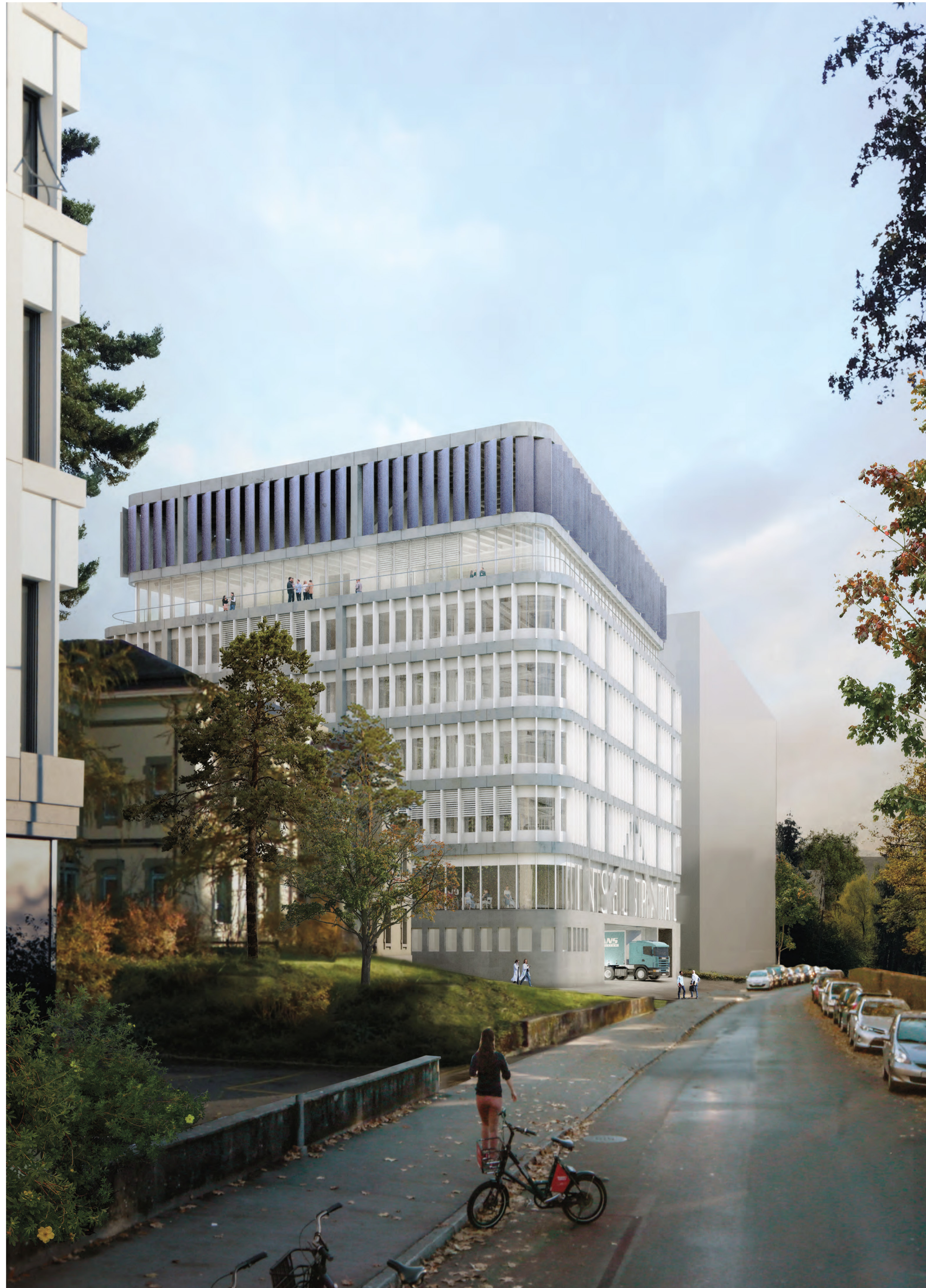
Blick von Norden entlang der Friedbühlstrasse. Die Anlieferung ist adressbildend als logistisches Eingangstor ins Areal
