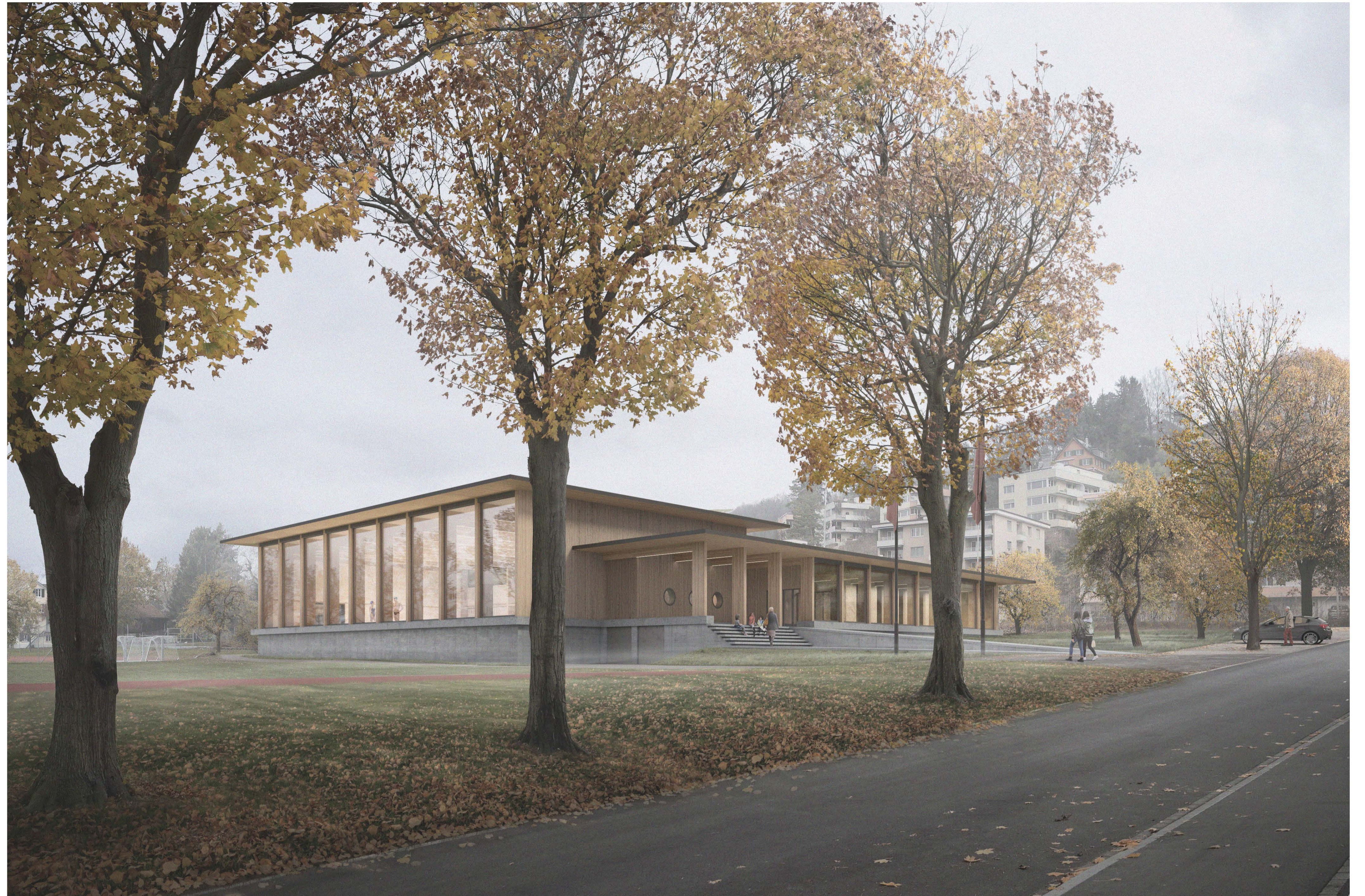
Ein massiver Sockel bildet eine solide Basis für den einfachen Holzbau. Vertikal belonte aussenliegende Tragstrukturelemente betonen das Emporstrebende. Ein weit ausladendes Flachdach bildet wie ein Kapitel den klassischen Abschluss. Das neue Bad setzt sich als heiterer, filigraner Holzbau ausgewogen in den Obstgarten.
