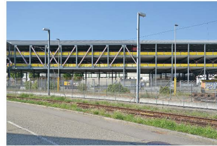
Das Parkhaus Ruchfeld wird zu einem dreidimensionalen Naturraum umgenutzt.
