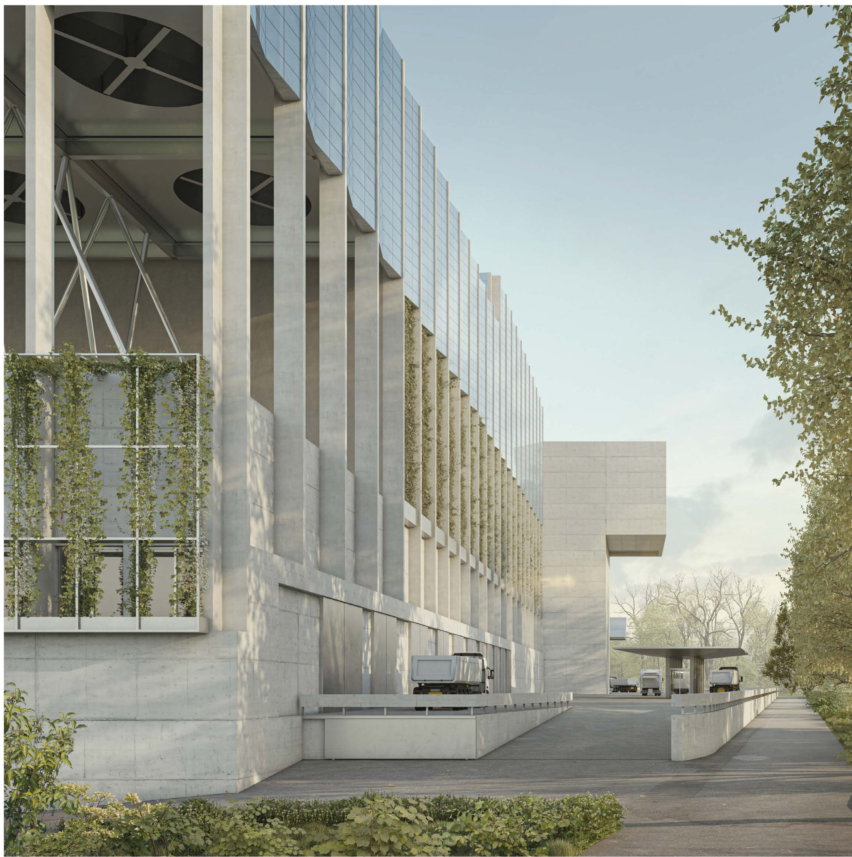
Auf der Südseite gliedert sich die Anlage in einen mineralischen Sockel aus Beton, der aufgetöten und mit wilden Reben begrünter Struktur aus Beton und Holzverbundwerkstoffen im Mittelteil sowie einem mit Photovoltaik eingehüllten Teil im obersten Bereich der Fassade, in welchem sich der Himmel spiegelt.
