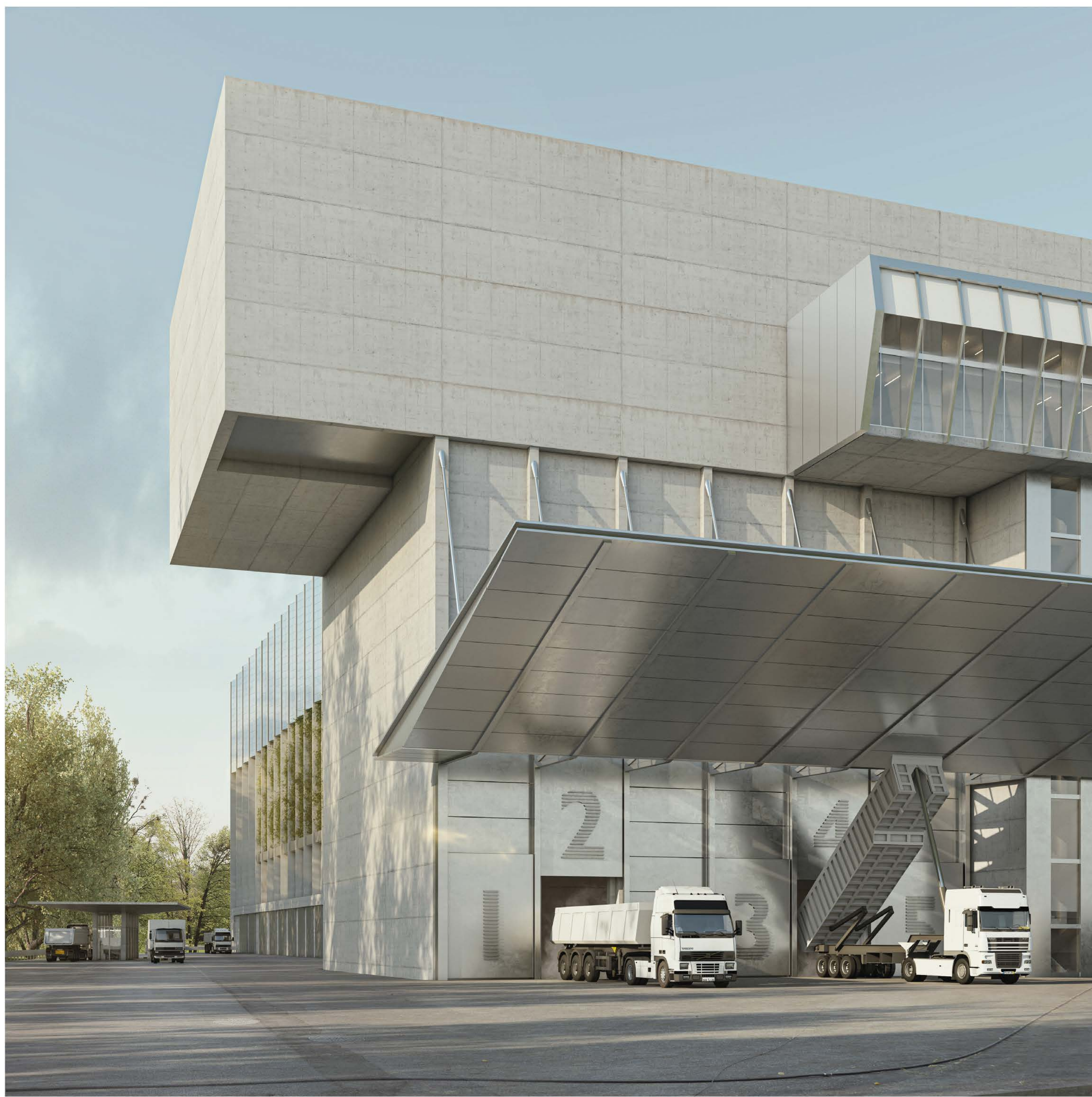
Gegen Osten wirft sich der mineralische Sockel hoch zum Bunkertrakt mit dem prägnanten metallenen Vordach über den Abwurföffnungen für die Anlieferung des Abfalls.
