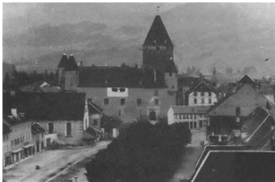
A droite la maison de l'horloger Delabays grandit jusqu'à masquer la façade principale. Démolition en 1967. A gauche, le local des pompiers supprimé au début des années 1970. État vers 1900, puis, ci-dessous, vers 1910-1920
