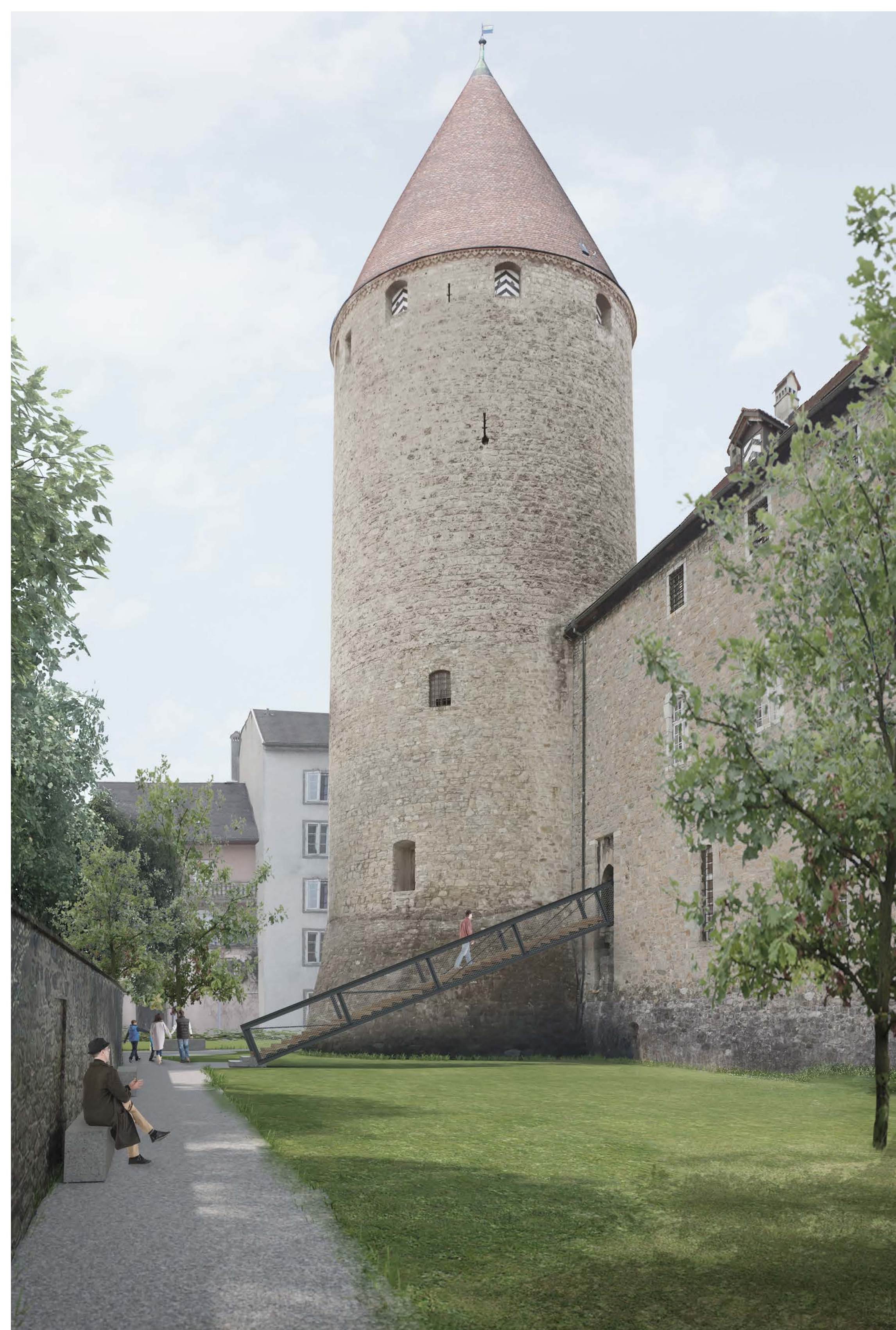
Douves et entrée Sud
