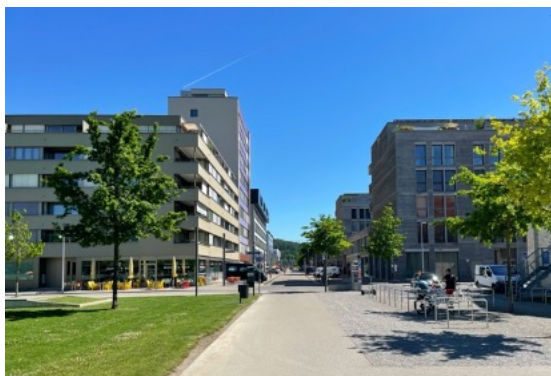
Eulachpark, Blickrichtung Else-Züblin Strasse
