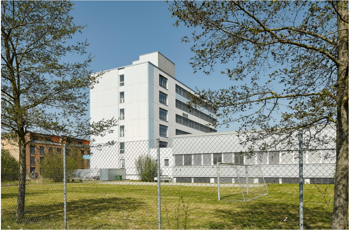
Bestand, Blick von Süden
