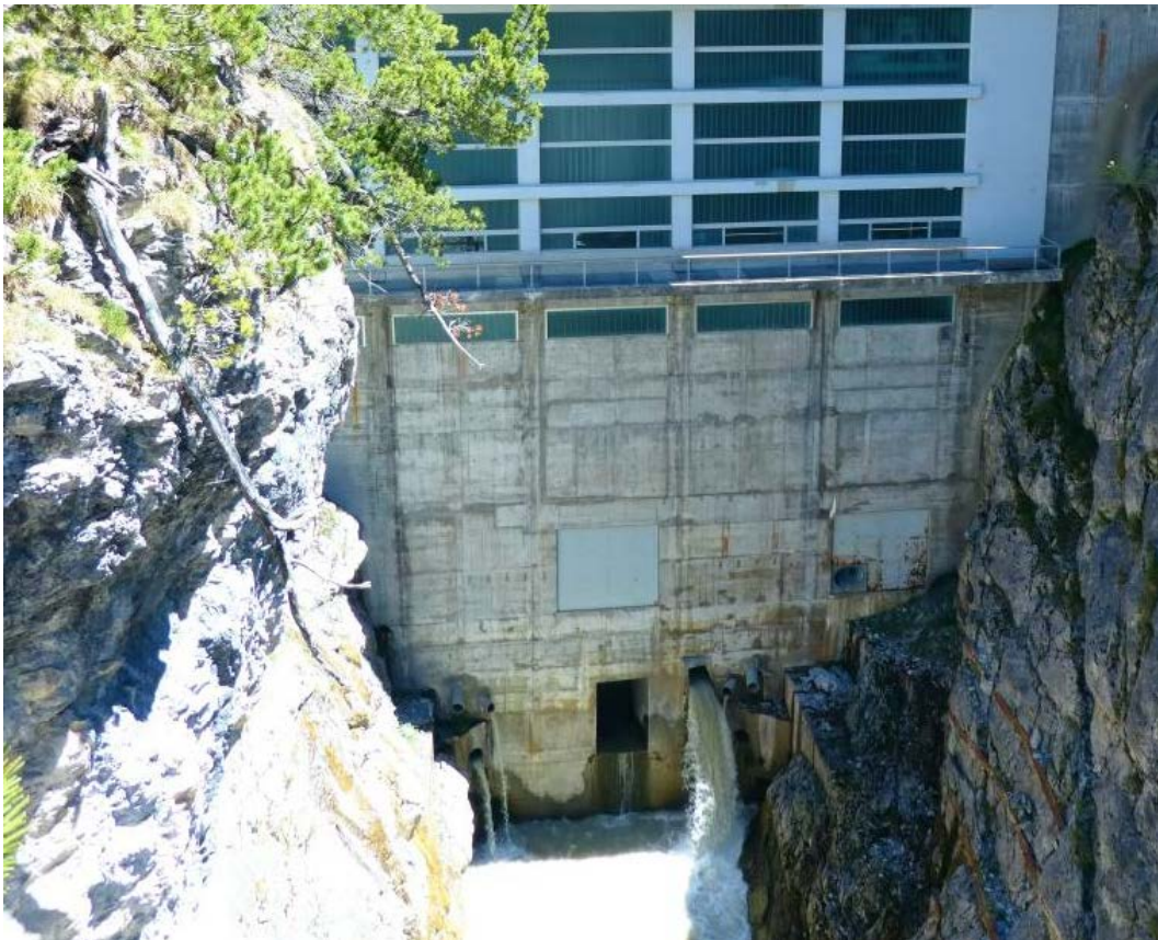
Abbildung 6: Mauerdurchlass und Unterwasserkanal der Dotierung
