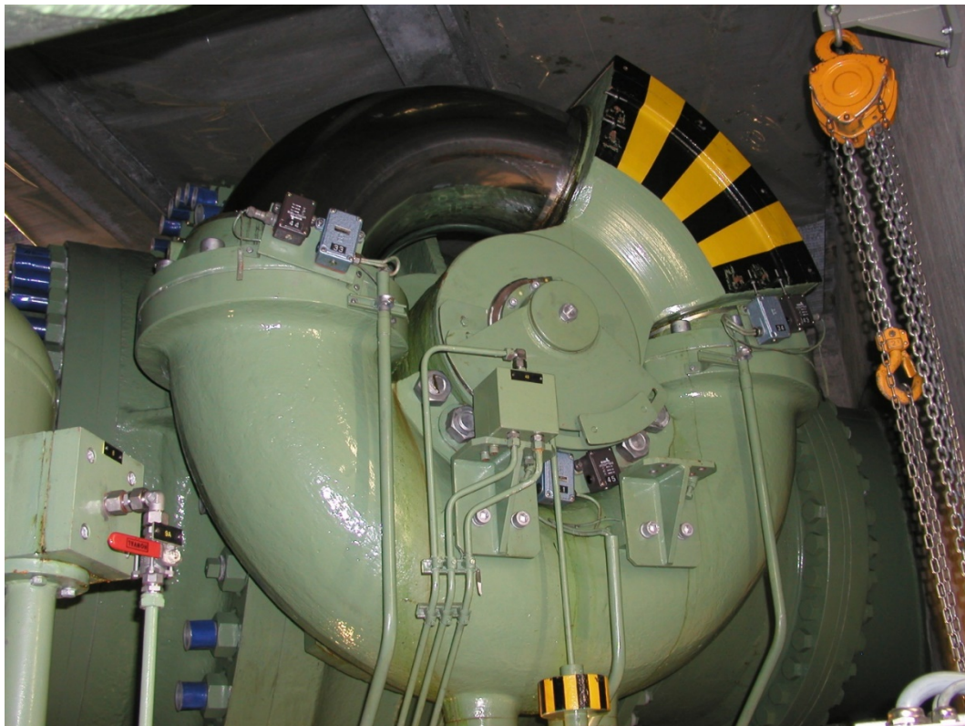
Abbildung 3: Kugelschieber mit Ringkolbenantrieb
