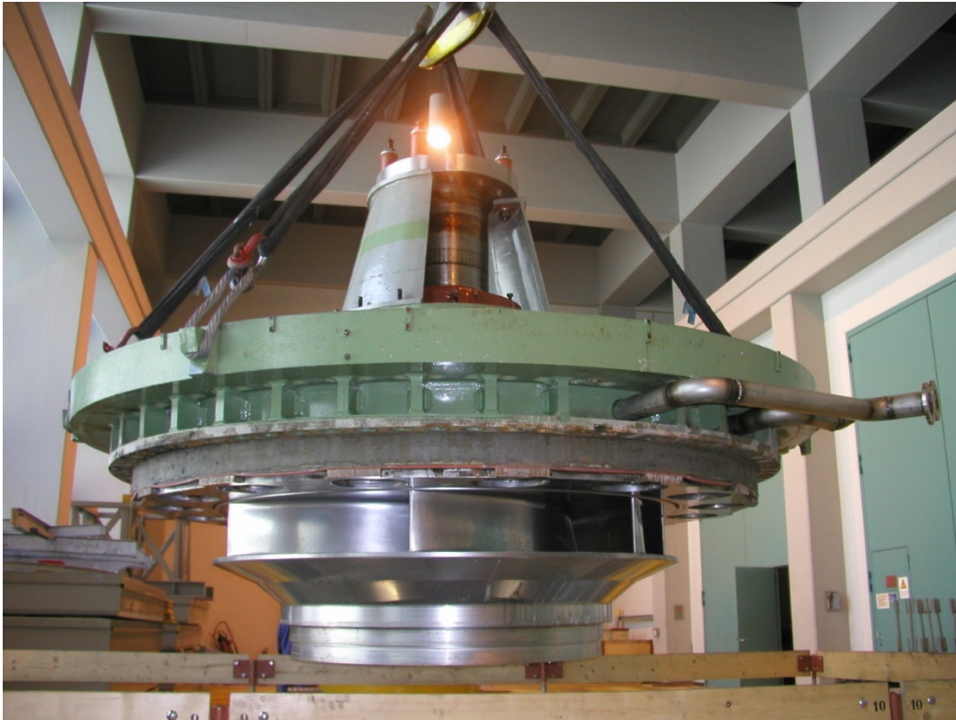
Abbildung 2: Pumpturbine Ova Spin (Demontage Turbinendeckel inkl. Laufwerk und Welle)
