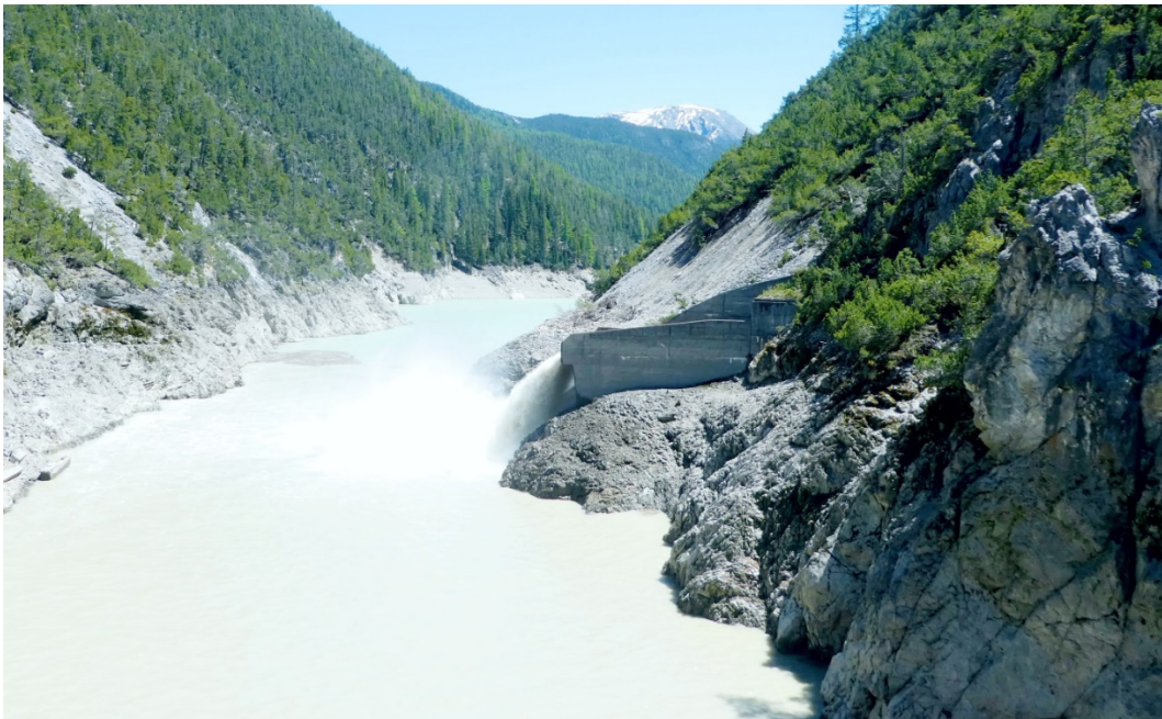
Abbildung 8: Mündung Freispiegelstollen S-chanf – Ova Spin
