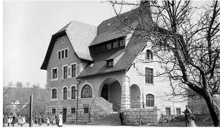
Denkmalgeschütztes Heimatlichschulhaus Hämgarten (1907) E. Sandreuter Architekt freistehender Sockelbau auf der Obstwiese mit Bindung zur traditionellen regionalen Baubauweise – Typologie mit topografischer Einbettung im Gelände Prägnanz durch die pädagogische Reformbewegung um 1900
