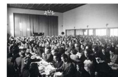
Der ehemalige Bodan-Saal Romanshorn
