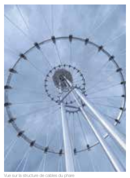
Vue sur la structure de cabine du phare
