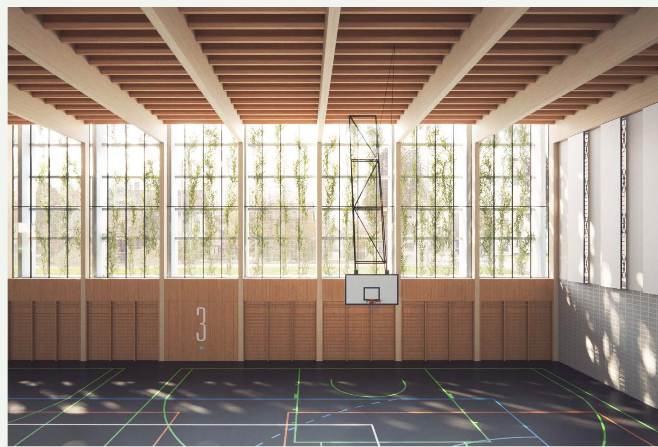
Architektonischer Sonnenschutz als bewachsener Brise Soleil, an der Seitenwand ist die Nachtsaukühlung sichtbar
