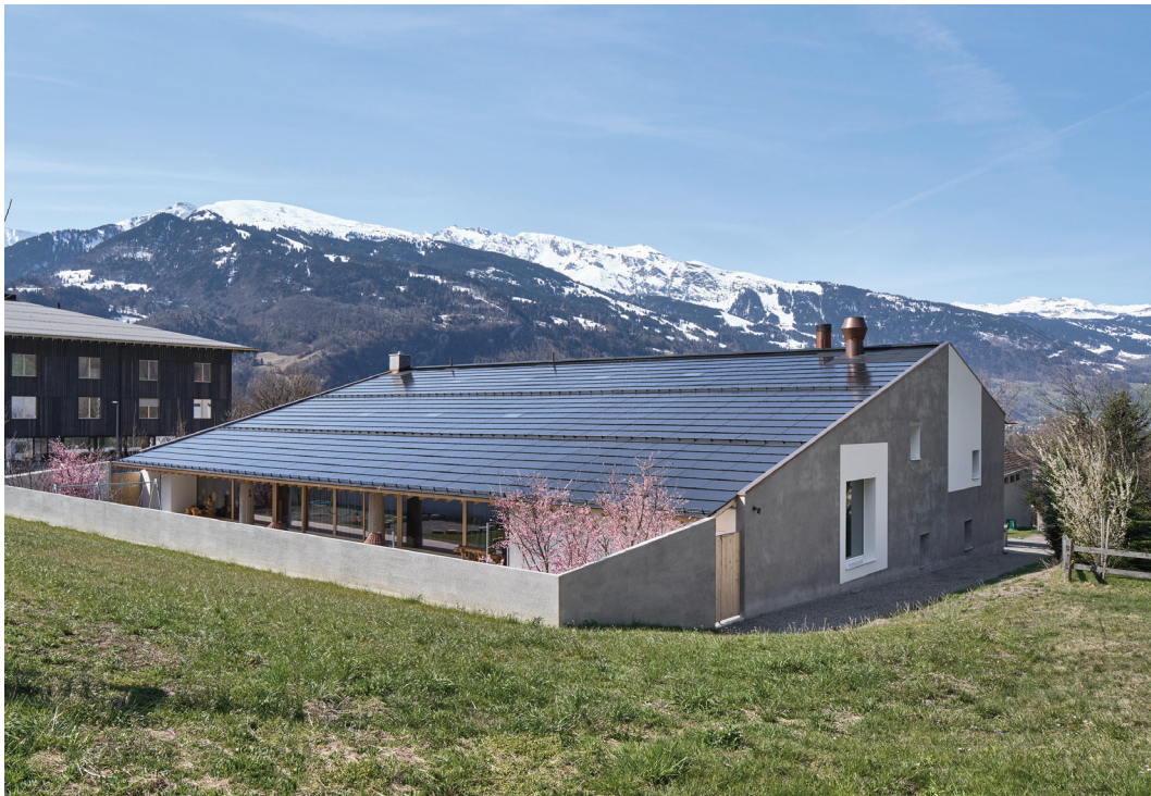
Fig. 1 Norman Foster Solar Award 2021: Rénovation BEP 275% d'un bâtiment polyvalent, Fläsch (GR)
