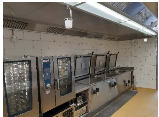
Arbeitslicht im Rücken des Arbeitsplatzes. Der Arbeitende gibt sich selber Schatten
