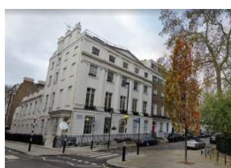
Angolo sud-ovest, situazione attuale
