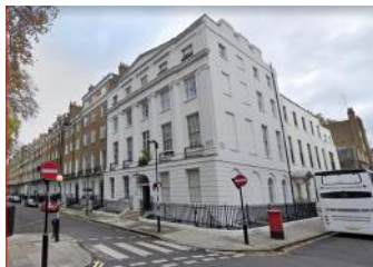
Angolo sud-est, situazione attuale
