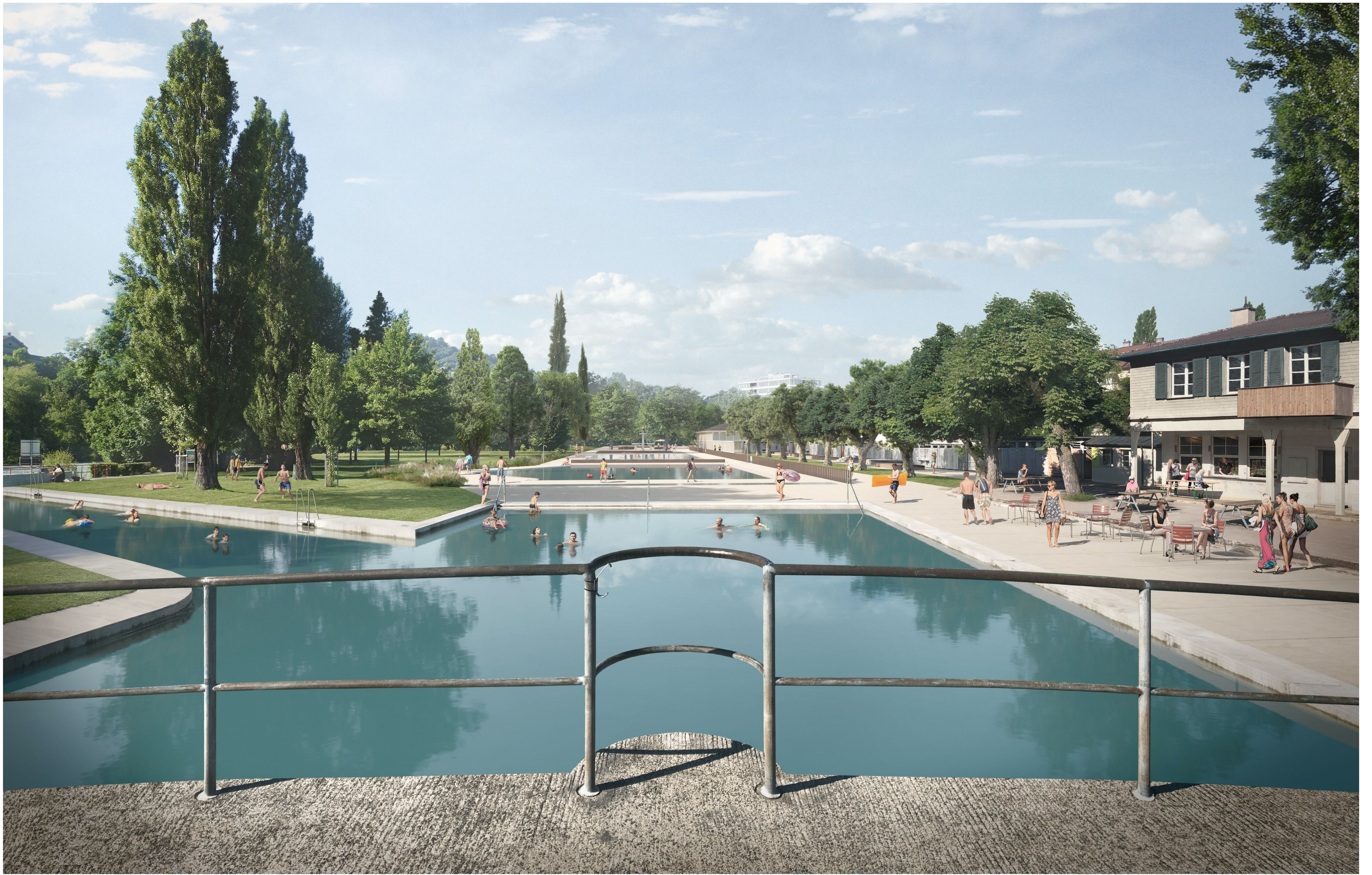
Bueberausstieg mit neuer Beckenanlage
