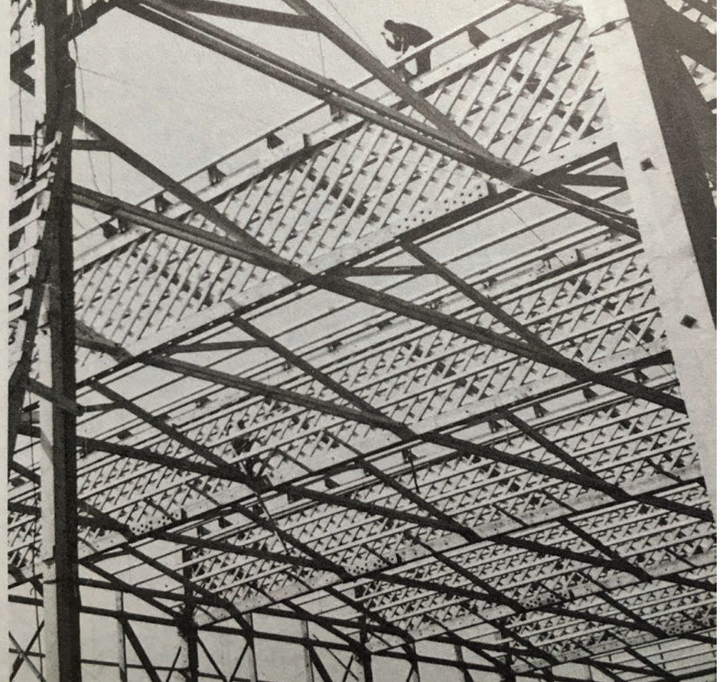
Gitterfachwerk binder Ausstellungspavillon Landi 39
