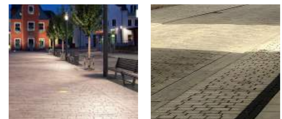
ebene Oberfläche Pflaster visueler Leitfaden
