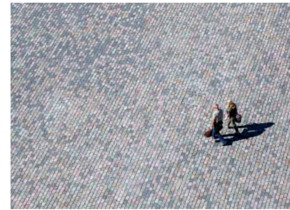
Flächiger Guberstein-Pflasterung mit Porphyr-Einsätzen
