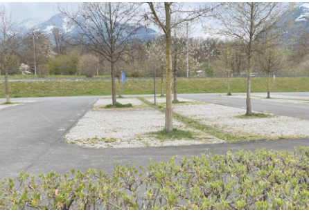
Stationnement sol en stabilisé
