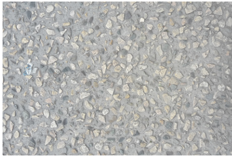
Dalle en béton lavé
