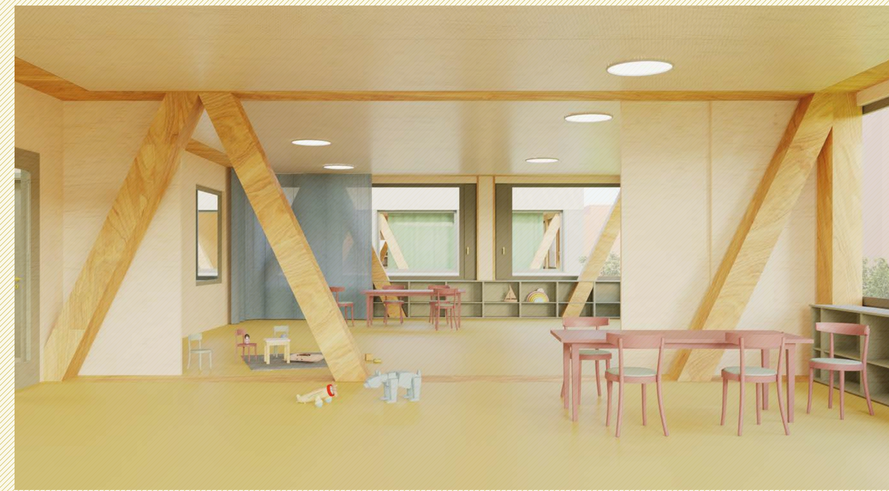
6 - Die Betreuung spannt mit ihren raumhohen Fachwerkträgern aus Schweizer Stabuche über die Doppelsporthalle.
