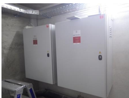
Mise en place d'un système d'éclairage de secours centralisé (2016)
