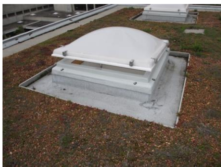
Remplacement des exutoires de fumée
