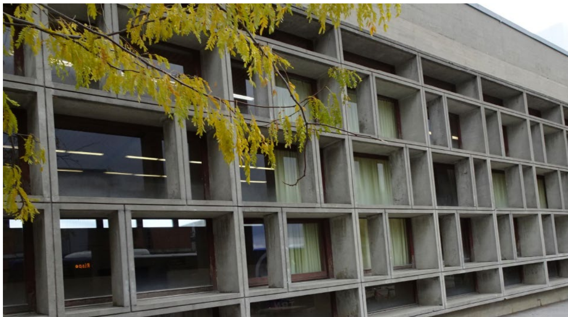
Raster poteau/traverses en béton porteur extérieur
