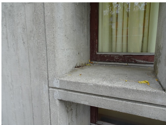
Photos 03-06 : raster béton extérieur formant brise-soleil
