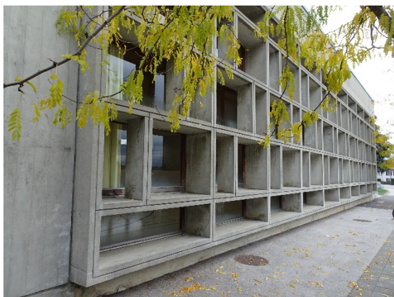
Photos 01-02 : raster béton extérieur formant brise-soleil
