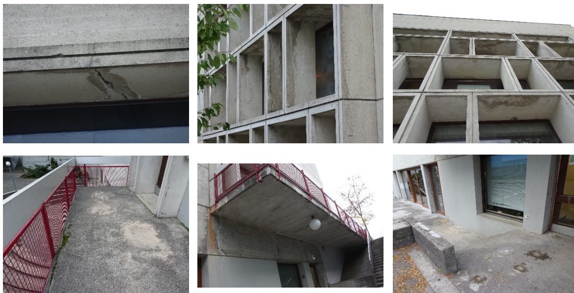
Photos 18-24 : fissures / infiltrations d'eau
