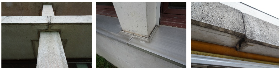
Photos 15-17 : joints exposés aux UV à remplacer
