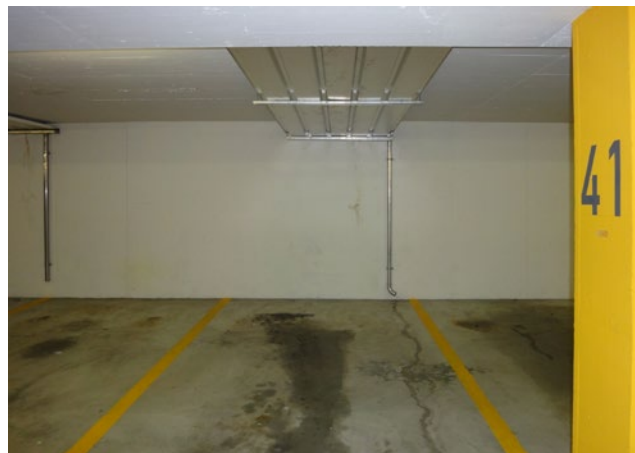
Tiefgarage, undichte Decke
