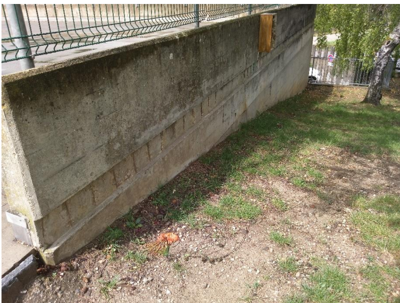
Image 10 : corrosion des armatures exposées (axes A', 1' et D')
