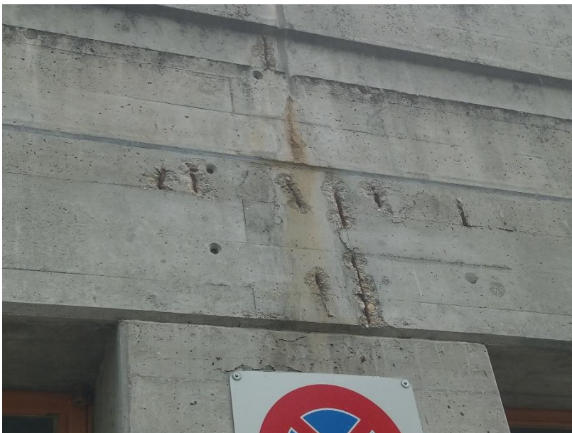
Image 6 : coulures d'eau par le joint du parapet et traces de corrosion des armatures (axes 1' – C')
