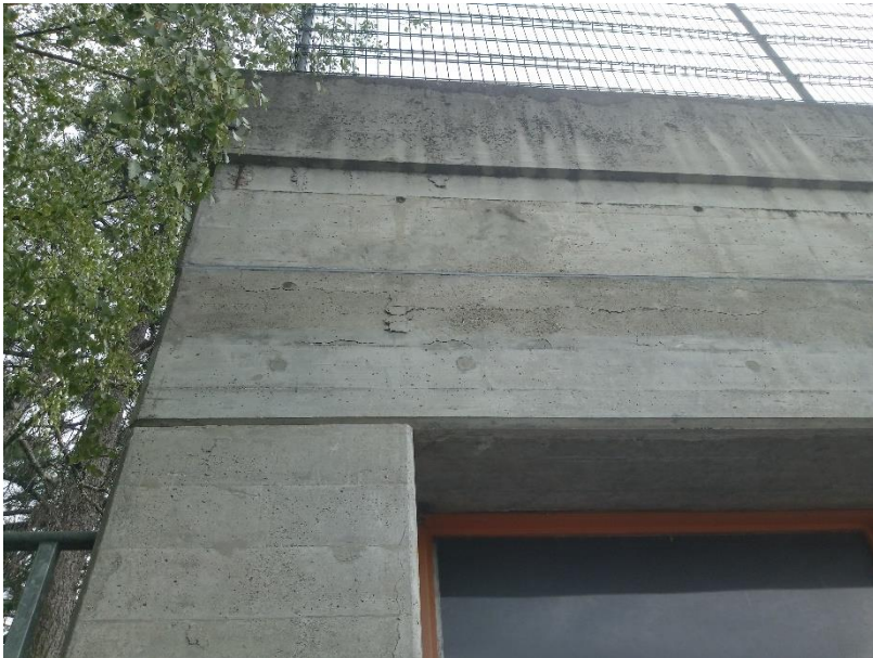
Image 8 : éclats du béton (axes 1' – A')
