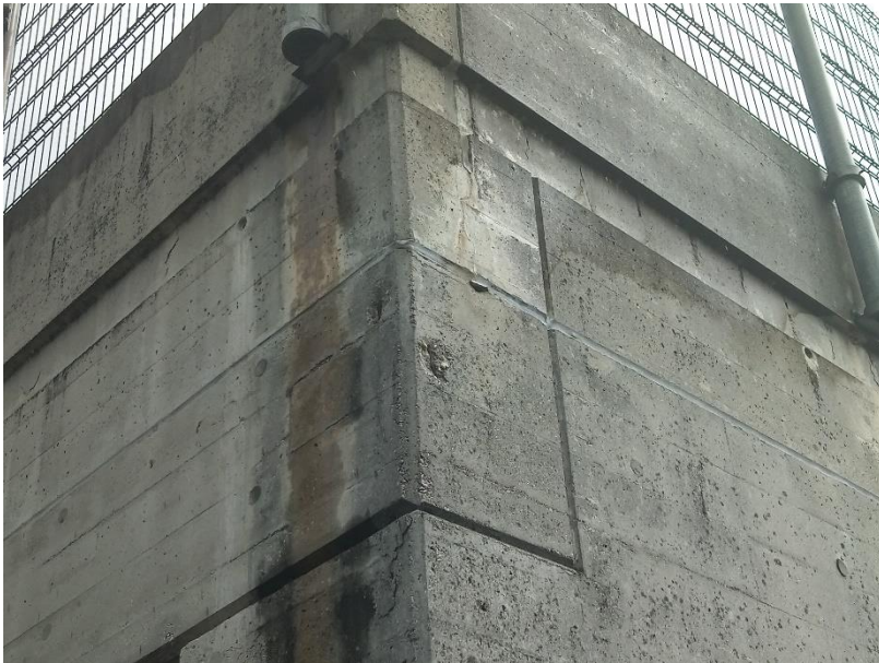
Image 5 : coulures d'eau et traces de corrosion ; armature sans enrobage, corrodées (axes 1' – D')
