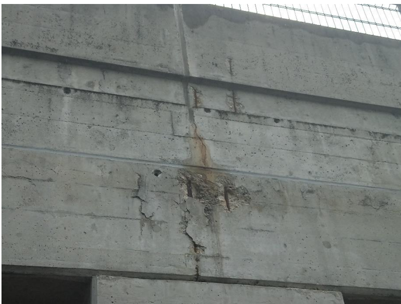
Image 7 : coulures d'eau par le joint du parapet, corrosion des armatures et éclats du béton (axes 1' – B')
