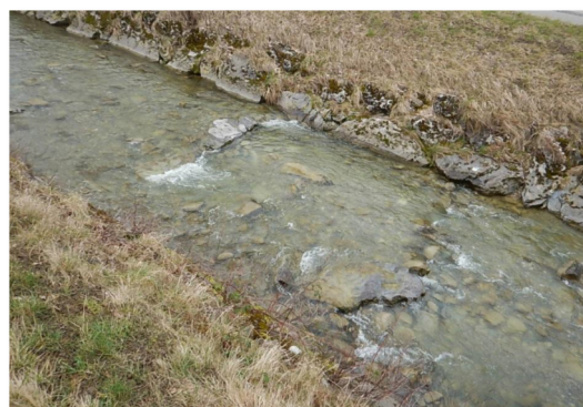
Abbildung 4: km 0.94; oberhalb Schuppisbrücke. Erosive Sohle mit Blöcken und Steinschwellen stabilisiert
