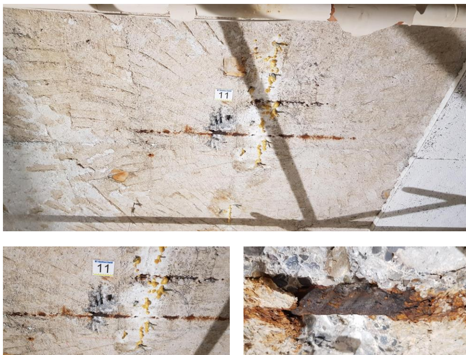
Abb. 17: Sondagestelle S-211, Untersicht Decke UG2, Rampe (unterhalb Einfahrtstunnel UG1) [MTQ]
