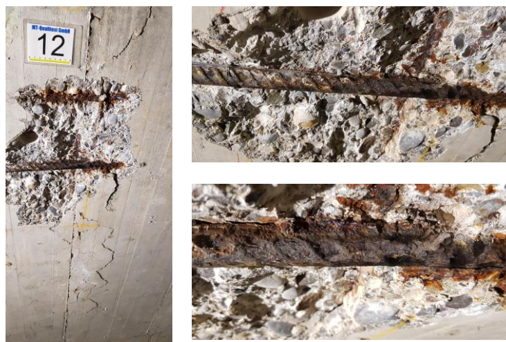
Abb. 18: Sondagestelle S-212, Untersicht Decke UG2, Tankraum (unterhalb Einfahrtstunnel UG1) [MTQ]
