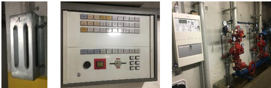
Abb. 6: Links: CO-Fühler; Mitte: Fernsignaltableau; Rechts: Sprinkleranlage
