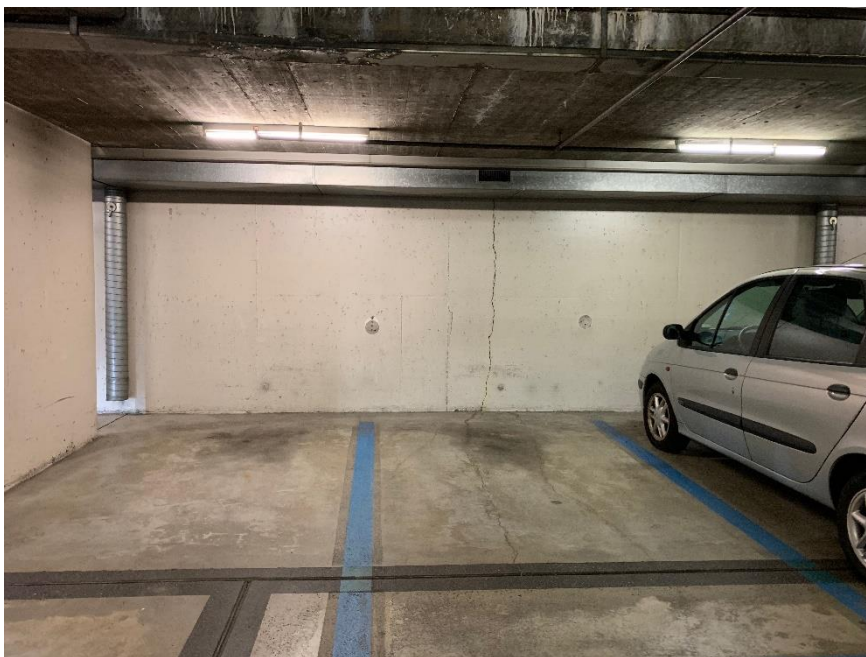
Abb. 10: Feuchte- und Risschäden im UG1
