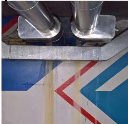
Abb. 7: Undichter Gebäudeeintritt
