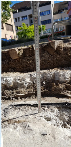
Deckenaufbau S01
