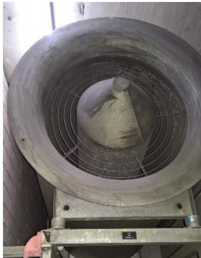
Abb. 8: Axial-Abluftventilatoren aus dem Jahr 1979
