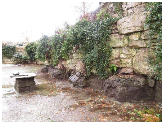
Abb. 91 Ententeich. Mauerwerk aus Laufener Jurakalk, erstellt auf Fundation von 1876
