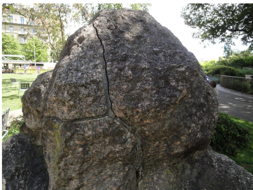
Abb. 85 Weltpostdenkmal. Detail Fels, für den Transport gespalten und in Bern zusammengefügt
