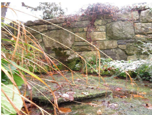
Abb. 119 Ungerichtetes Mauerwerk Ententeich (1948), vermengt mit Felsbrocken von 1876
