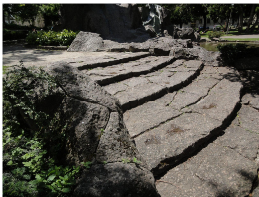
Abb. 86 Weltpostdenkmal. Flache Rampentreppe aus Granit der Bretagne. Ausführung Frühjahr 1909
