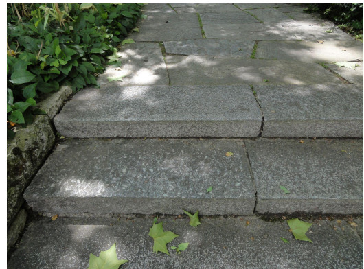
Abb. 108 Wegbeläge. Granitvollstufe von 1948
