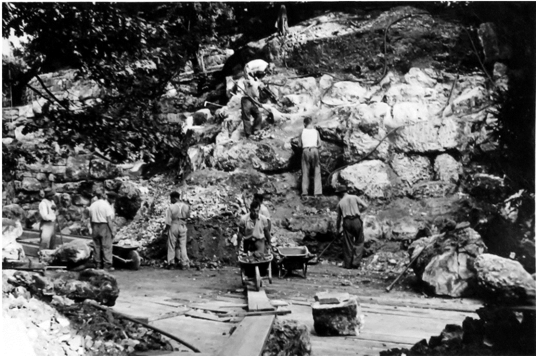
Abb. 47 Fotografie (Aug. 1949). Abbrucharbeiten der künstlichen Felsen. Zu sehen sind die Fundationen des Gosset'schen Bauwerks: unbehauene Felsen und Beton. Q: Fotoslg. SGB «Kleine Schanze».
