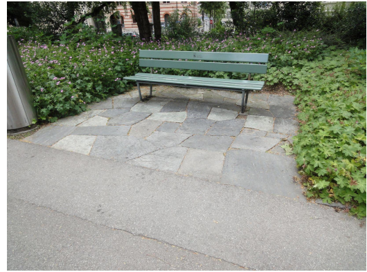
Abb. 106 Wegbeläge. Polychrome Polygonalplatten
